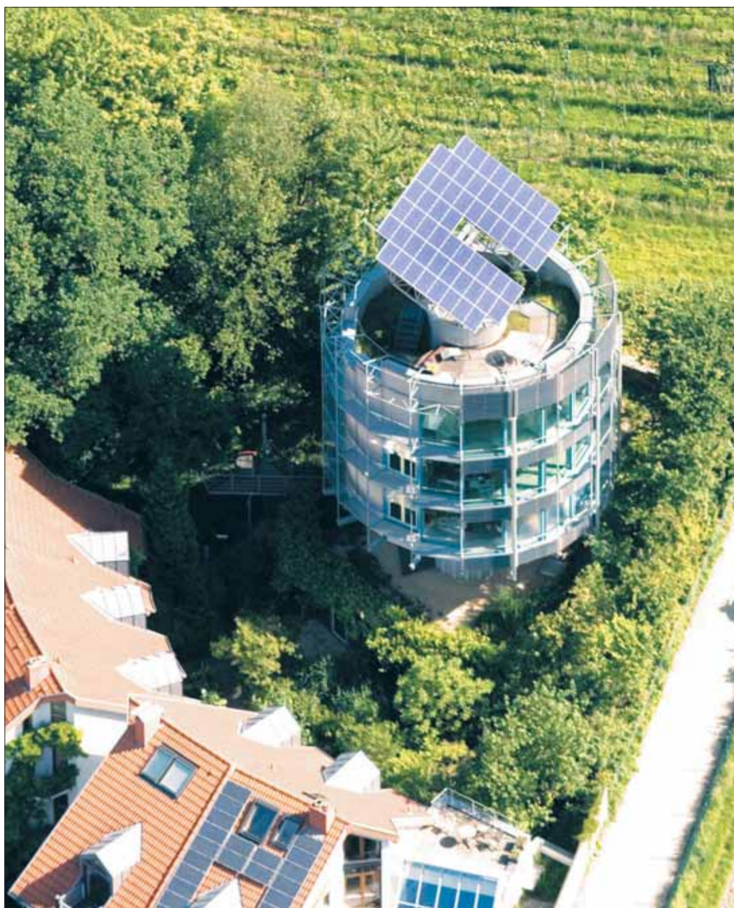
Rolf Dischs „Heliotrop“-Prototyp in Freiburg: Das Haus dreht sich um die eigene Achse, um das Licht optimal zu nutzen. An heien Tagen zeigt es der Sonne seine speziell isolierte Seite und bleibt dadurch khl.
